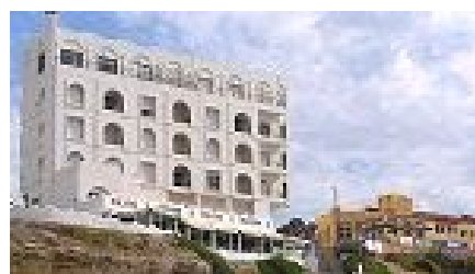
Edificio “Mirador Azul”
